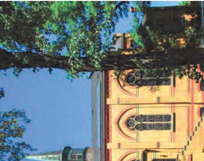
Der 1922 errichtete Kirchenbau in expressionistischer Formensprache steht mit der Schmalseite zur Straße. Bei der Neindeckung des Daches mit Natur-Schiefer wurde über dem Kirchsaal eine rechteckige Fläche PV-Module in das Dach flächenbündig integriert. Aufgrund der maßvollen Größe der Anlage und gestalterischen Einfügung in das Dach steht für den Betrachter weiterhin das Denkmal mit seiner prägenden Architektur im Mittelpunkt.
