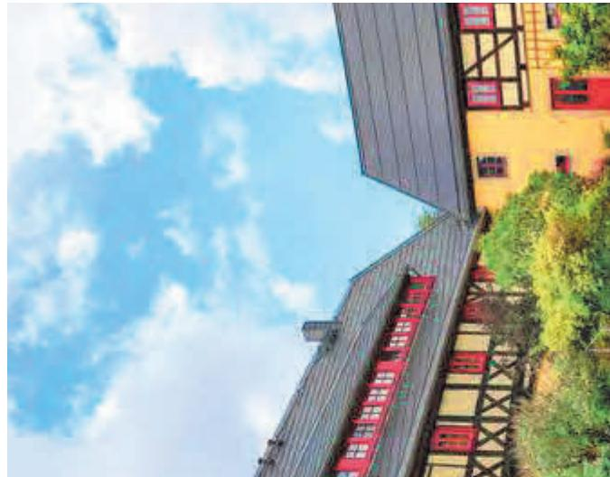
Das Pfarrhaus in Ortsrandlage wurde mit einer Anlage aus dunklen, randlosen Standardmodulen als Aufdachvariante versehen. Auf dem dunklen Dach treten die Module nur wenig in Erscheinung. Für die halböffentliche Nutzung mit hohem Energiebedarf ist die solare Unterstützung ein wesentlicher Faktor zur Kostenenkung.
