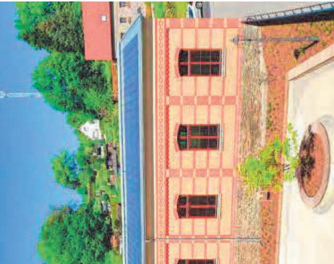
Auf dem nachkriegsmodernen Flachdachbau sind die leicht aufgesänderten Module hinter der Attika aus dem Straßenraum nicht sichtbar. Auch in der Aufsicht treten sie nicht in Konkurrenz zu der vorgehängten Rasterfassade des Gebäudes. Bei modernen Flachdachbauten ist die Integration von Photovoltaikanlagen gestalterisch zumeist einfach möglich, sofern die statischen Gegebenheiten dies zulassen.
