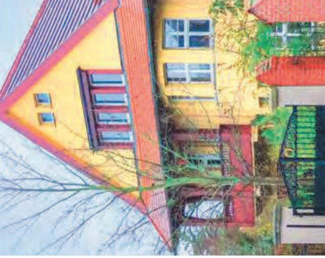
Diese Villa steht in einem städtischen Villengebiet. In die rote keramische Dach-eindeckung der Südseite wurde eine Photovoltaikanlage integriert. Die Höhe der einzelnen, länglichen Module entspricht der Ziegelhöhe auf dieser Dachfläche; die anderen Dachflächen haben weiterhin die noch kleinteiligeren Biberschwanz-deckung. Die Module sind farblich den roten Ziegeln angepasst. So bleibt der Eindruck eines kleinteilig gegliederten Daches erhalten.
