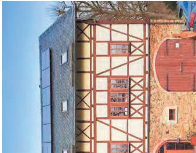
Das Umgebindehaus wurde Ende des 18. Jahrhunderts in Tällage am Ortsrand errichtet. Im Rahmen der Neuerdeckung des Daches mit Schiefer wurde auf der zentralen Gaube der ortszugewandten Dachfläche eine integrierte Solaranlage ausgeführt.
